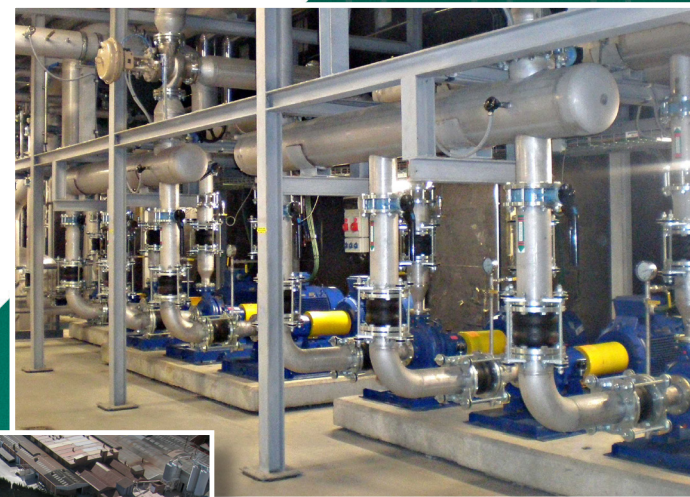
KSB kølepumper til partikelacceleratoren “Synchrotron Alba”. (Copyright ©KSB Aktiengesellschaft, Frankenthal)
