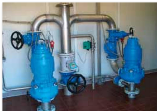
Tørtopstillet pumpestation klar til brug
