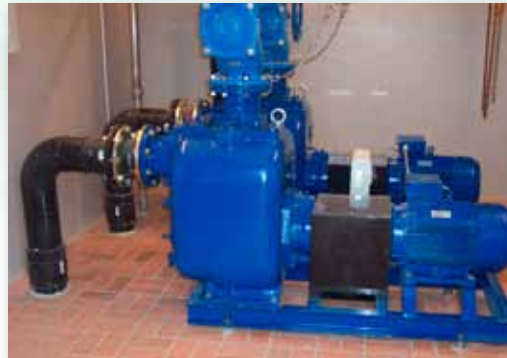
Tørtopstillet, selvansugende pumpestation klar til brug
